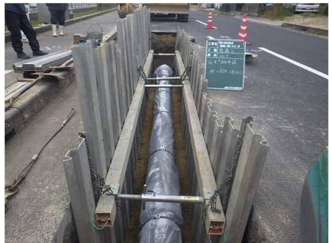
管路の耐震化(更新工事)の様子
