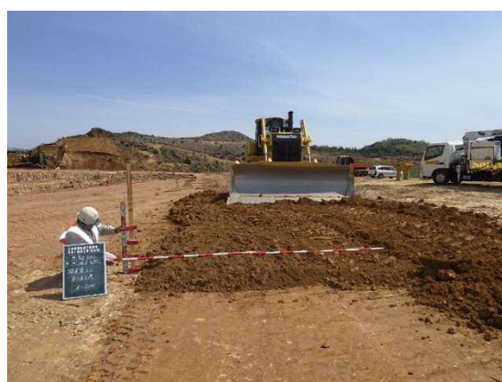
工事中のF区画
