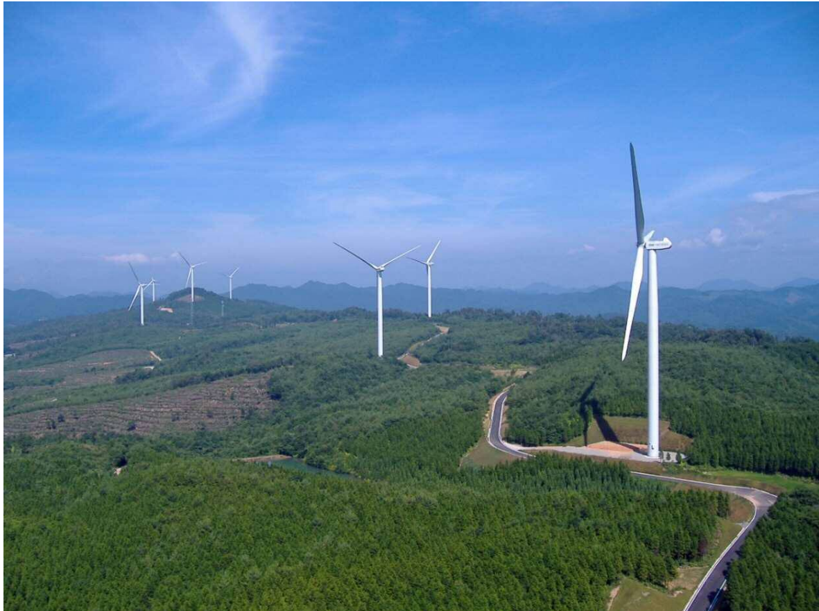
高野山風力発電所（江津市二宮町、敬川町、千田町）
