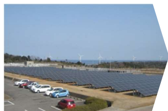
西部事務所と 太陽光発電所
