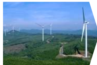
江津高野山 風力発電所
