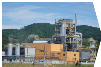
バイオマス発電所 他関連施設
